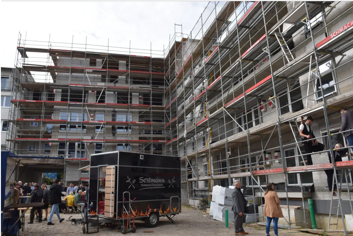
Ein Blick in den Innenhof. Dort fand nun auch das Richtfest statt. FOTO: BJÖRN DIECKMANN
